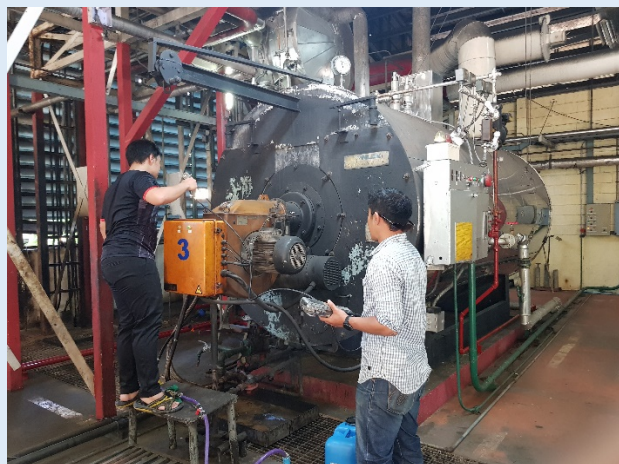
การทดสอบการใช้ไบโอออยในหม้อไอน้ำที่โรงพยาบาลศรีนครินทร์ มหาวิทยาลัยขอนแก่น
